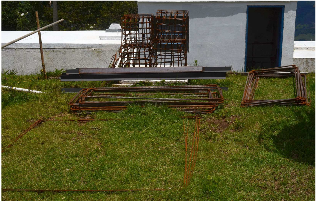
Fig. E.3 – As armações das ferragens das bases já montadas de acordo com o projeto original e que se pretende aproveitá-las no atual projeto.
