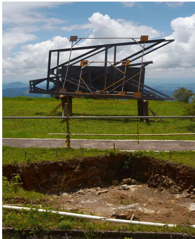
Fig.D 2 - A vala com aproximadamente 1 m de profundidade com as estruturas das torres ao fundo.
